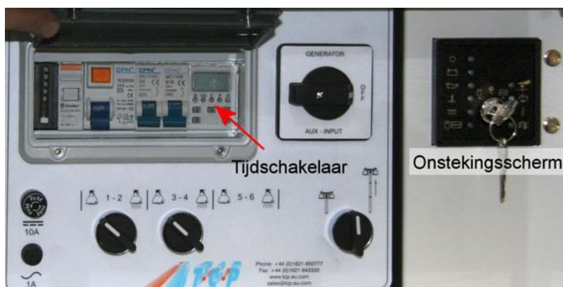
Afb A1 Tijdschakelaar en ontstekingsscherm
